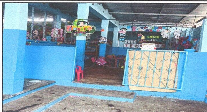
Foto1: Renglón 1.1 Suministro e instalación de puerta principal de metal medidas 101 de ancho por 3.40 en aulas
