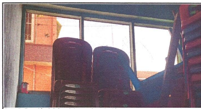
Foto 5: Renglón 2.2 Suministro e instalación de ventana corrediza de upvc con vidrio claro de 5 mm
