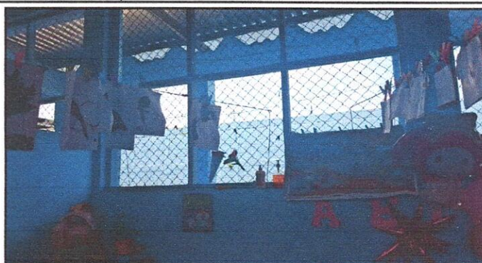
Foto 2: Renglón 1.2 Sustitución de ventana de marco de madera con malla por ventana de upvc con vidrio claro
