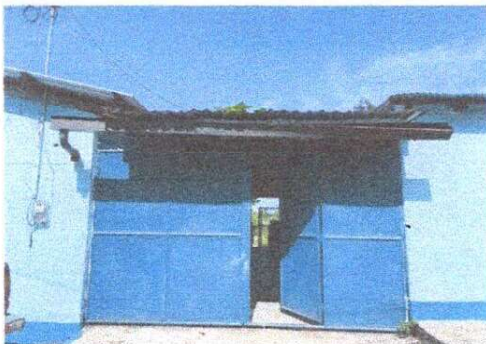
Foto1: Reparación de portón
