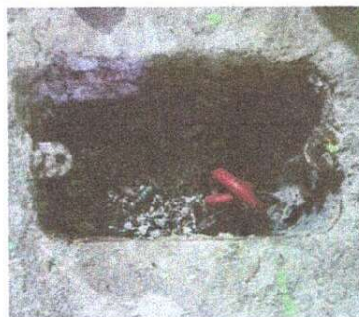
Foto 6: Reparación de sistema eléctrico
