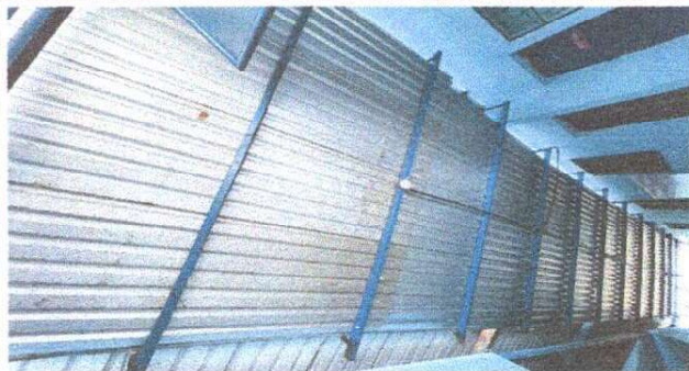
Foto 2: Estructura de techo y cubierta de lamina
