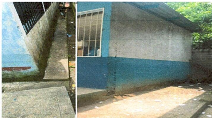
Foto 3: reparacion de plancha de concreto de patio
