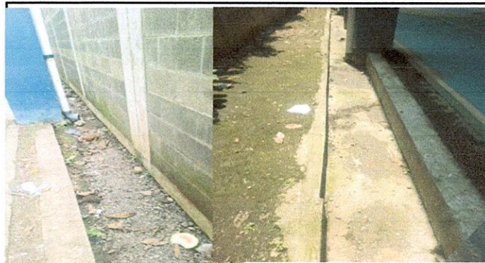
Foto 2: reparacion de cuneta de concreto
