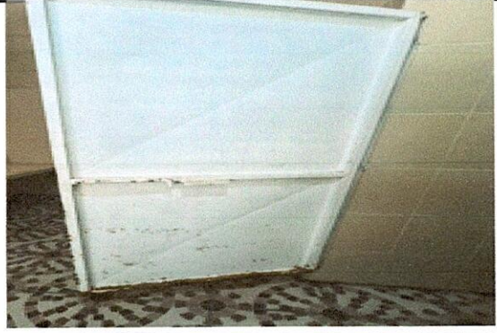
Foto 2: Mantenimiento de Puertas.
