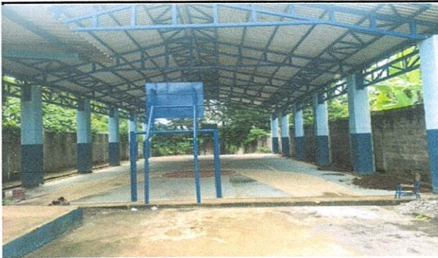
Foto1: Pintura en muros Exteriores e Interiores.
