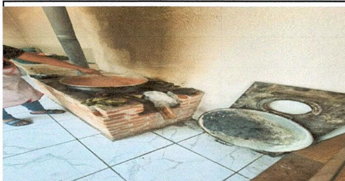
Foto 5: repación de estufa rural (completa)
