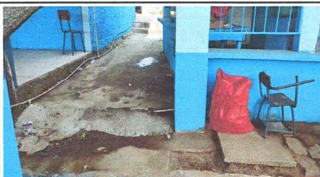
Foto 4: Sustitución losa de patio de concreto
