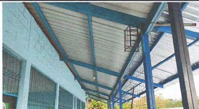
Foto 8: Suministro de cielo falso
