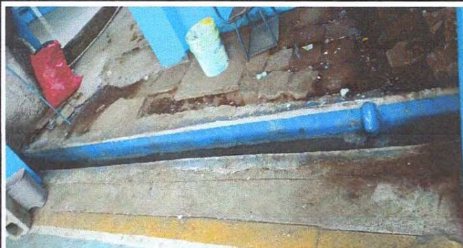
Foto 1: Suministro e instalación de rejillas y sustitución de concreto en cuneta
