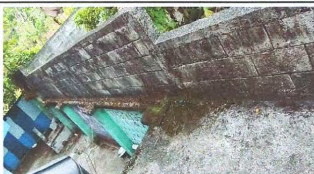
Foto 10: Aplicación de pintura en muro perimetral
