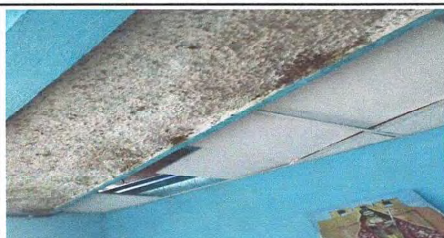
Foto 12: Sustrucción de cielo falso
