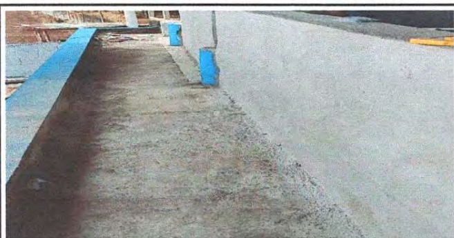
Foto 11: Aplicación de pintura
