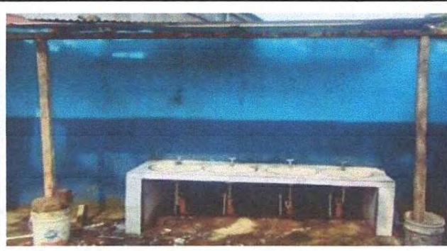
Foto 2: Sustitución de cubierta de lámina y estructura
