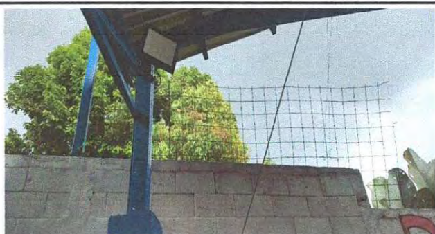
Foto 5: Sustitución de electromalla por tubo galvanizado con malla galvanizada
