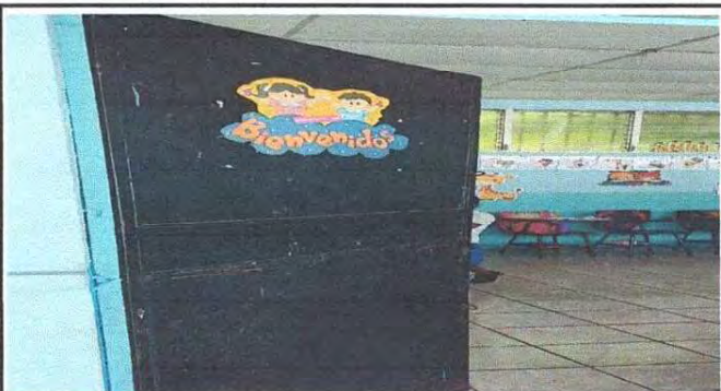
Foto 3: Sustitución de puerta de metal
