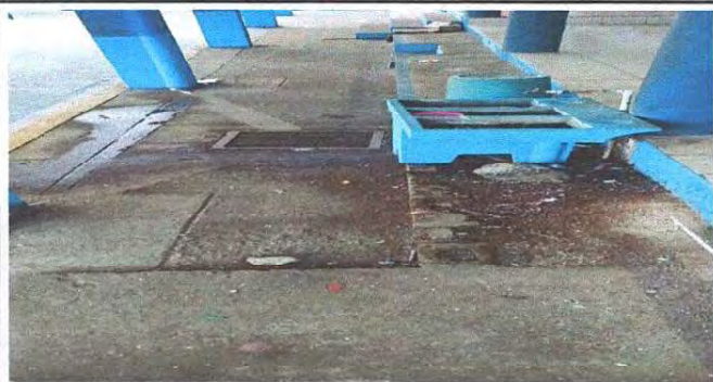
Foto 7: Sustrucción de losa de patio de concreto
