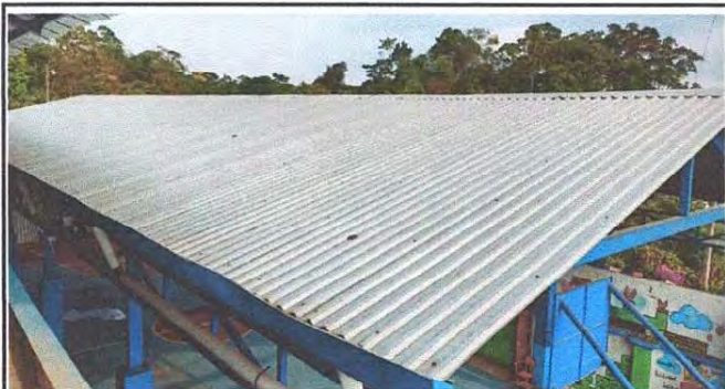
Foto 9: Aplicación de pintura anticorrosiva en cubierta de lámina
