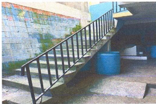
Foto 8: SUMINISTRO E INSTALACION DE PASAMANOS TUBO NEGRO Ø 2" 1.15X8.00MTS (INCLUYE PAGO DE MANO DE OBRA)
