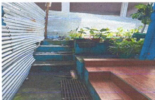
Foto 7: SUMINISTRO DE CONCRETO PARA RAMPA t:0.10 1.15X8.00MTS INCLUYE RELLENO
