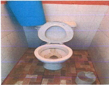
Foto 1: SUSTITUCION DE INODOROS
