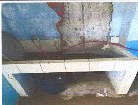
Foto 9: SUMINISTRO DE MESA PARA LAVAMANOS DE CONCRETO CON AZULEJO
