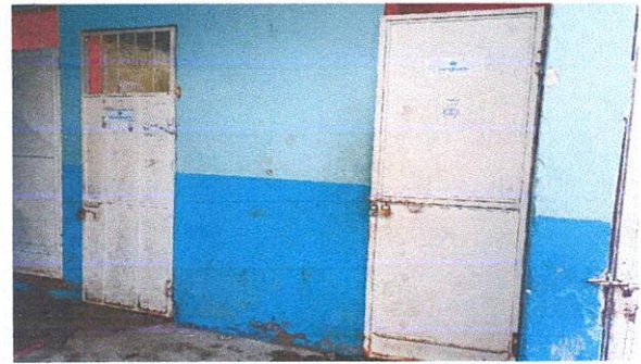
Foto 2: MANTENIMIENTO A PUERTAS DE METAL LIJADO, CEPILLADO Y PINTADO (INCLUYE PAGO DE MANO DE OBRA)
