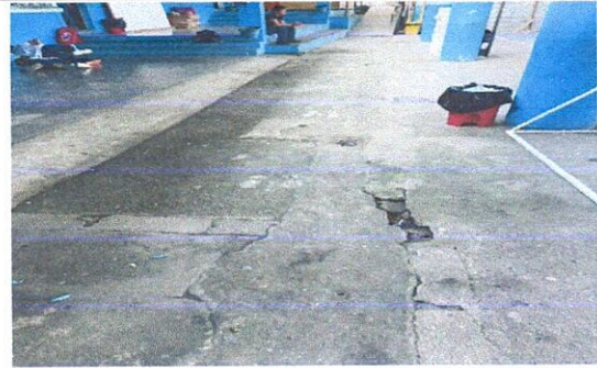
Foto 6: SUSTITUCION DE RED DE DRENAJE TUBO NARANJA Ø 3"
