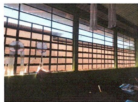
Foto 6: Suministro de balcones y sustitución de ventanas
