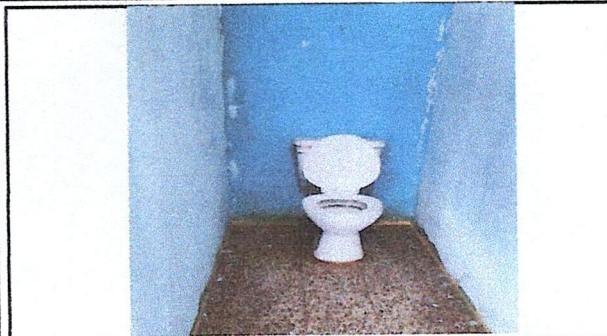
FOTO 1: Sustitución de accesorios de inodoros.
