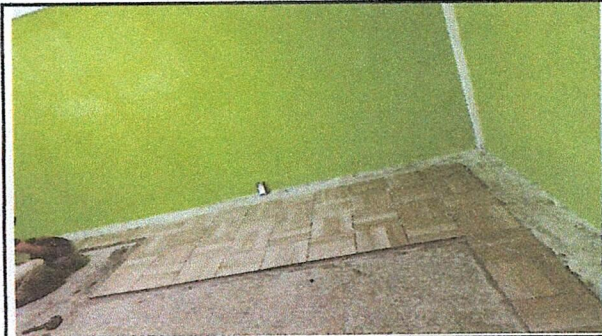
FOTO 4: Sustitución de piso, por cerámico.
