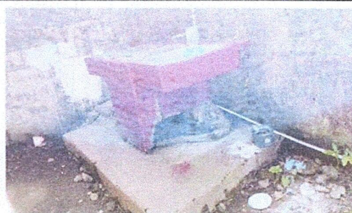
FOTO 2: Suministro de pila de concreto de 2.20 x 1.00
