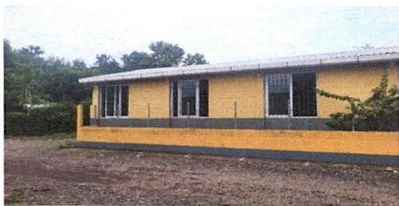
Foto 5: Sustitución de malla metálica en muro perimetral lado izquierdo por instalación de balcones de hierro en pared perimetral.
