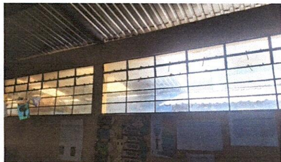
Foto 1: Sustitución de ventanas y balcones existentes por ventanas de PVC corredizas color blanco y balcones de hierro en la parte trasera del módulo 1.
