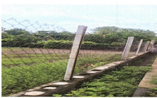
Foto 4: Sustitución de circulación perimetral con block y malla metálica por levantado de block sisado con columnas.
