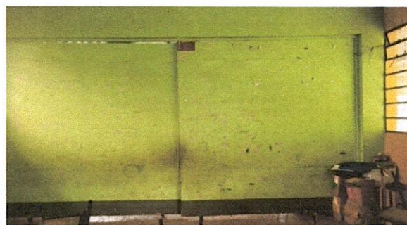
Foto 3: Sustitución de portón de plywood abatible de dos hojas por portón metálico, abatible de dos hojas, doble cara, con bisagra de vaivén.
