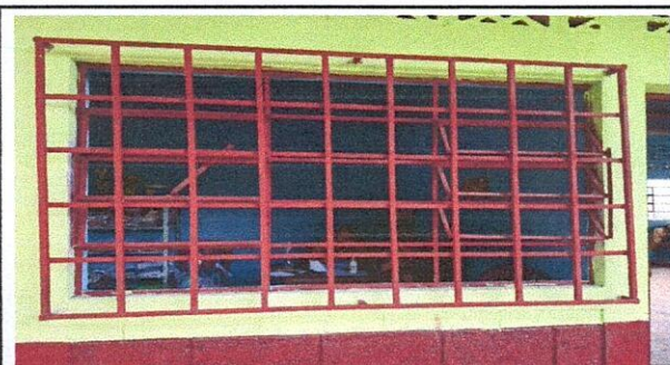
FOTO 3: SUMINISTRO EN MANTENIMIIENTO DE BALCONES
