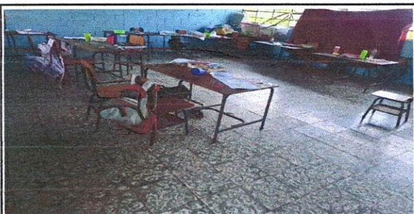
FOTO 4: SUSITTUCION DE PISO POR PISO CERAMICO
