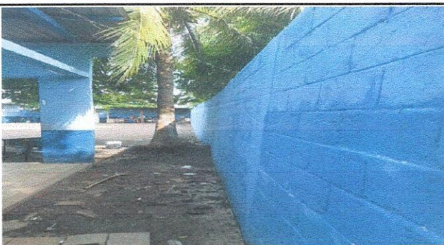
FOTO 5: Reparación de muro perimetral de block
