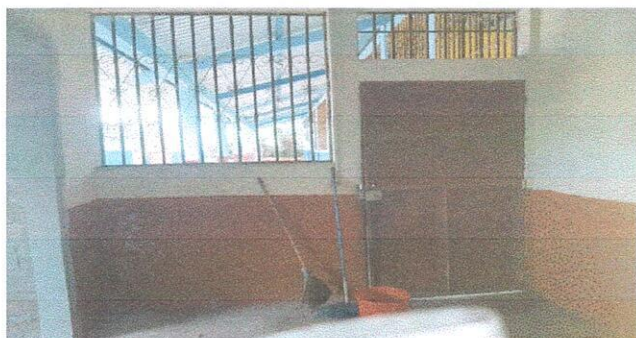
FOTO 1: Apertura de vano de ventana de 1.50 x 1.40 + apertura de vano de puerta de 2.20 x 1.00 + suministro de mesa de concreto (para alimentación) + cerramiento de puerta de 1.00 x 2.20
