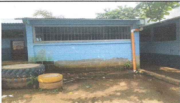
FOTO 3: Aplicación de repello en muros interiores y exteriores
