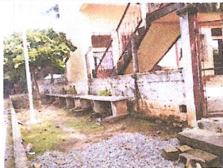
FOTO 2: SUMINISTRO DE REPELLO EN MUROS EST/ INT EN MUROS CERCANAS A CANCHA DE FUTBOL + PORTON DE METAL
