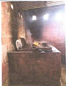
FOTO 3: SUSTITUCION DE ESTUFA RURAL + FACHALETA DE LADRILLO EN LO LATERAL+CHIMENEA DE CONCRETO
