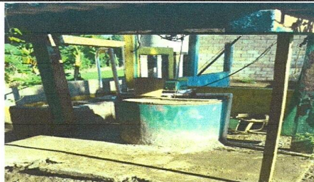
FOTO 2: Reparación de muros de pozo de 1.60 x 1.60 metros (incluye aplicación de repello cernido)
