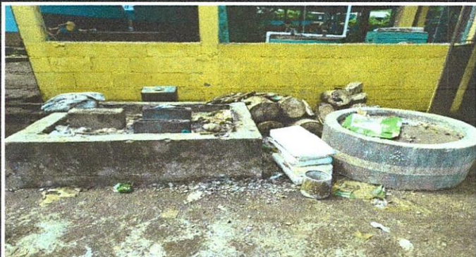
FOTO 1: Sustrucción de estufa rural de 0.80 x 1.80 (completa, incluye chimenea y plancha de metal)
