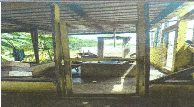
FOTO 4: Sustrucción de puertas de metal de 1.00 x 2.20, Sustrucción de malla, por balcón de metal
