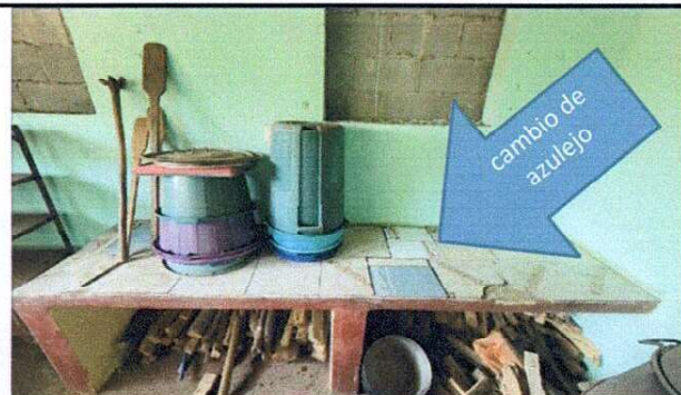
Foto 2: 1.1.2 (Reparación de Azulejo en mueble de cocina )(area de trabajo cocina)
