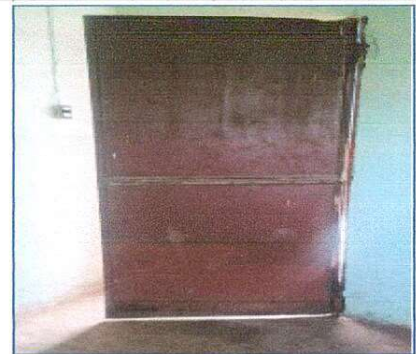
Foto 8: 1.5.1 Sustitución de puerta
