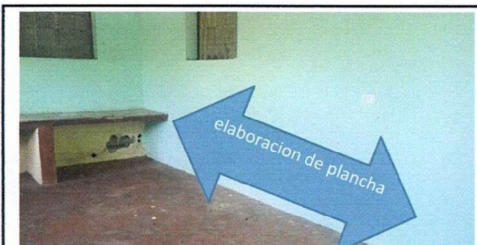
Foto 3: 1.1.3 Suministro de plancha de concreto debidamente azulejado (area de trabajo cocina)
