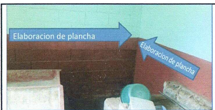
Foto 5: 1.2.1 Suministro de plancha de concreto debidamente azulejado (area de despacho)
