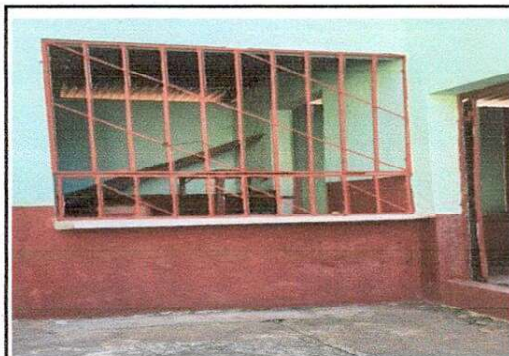
Foto 9: 1.6.1 Sustitución de balcon de metal por cortina enrollable de metal
