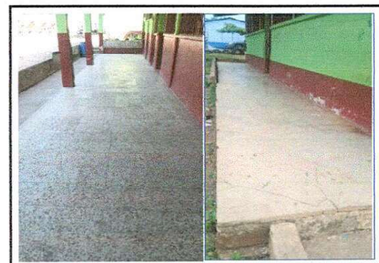
Foto 12: 3.1 Sustitución de piso de torta de concreto por piso ceramico.
