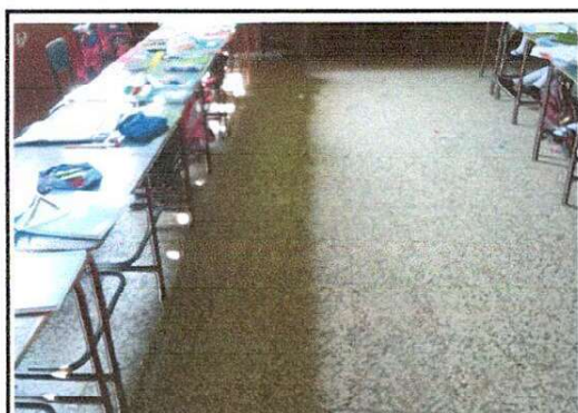
foto 11: 4.1 SUSTITUCION DE PISO DE GRANITO POR CERAMICO
