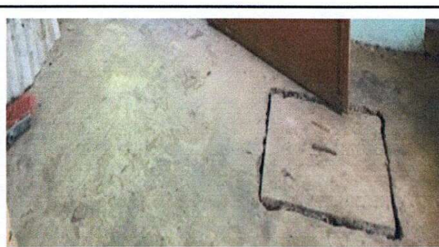
Foto 4: 1.1.4 ( Sustitución de piso de torta de concreto por piso ceramico)(area de trabajo cocina)
