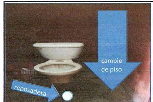
Foto 10: 2..1.1Sustitución e Instalacion de inodoros. 2.3 Sustitución de piso de torta de concreto por piso ceramico, 2.3.1 instalacion de reposadera
