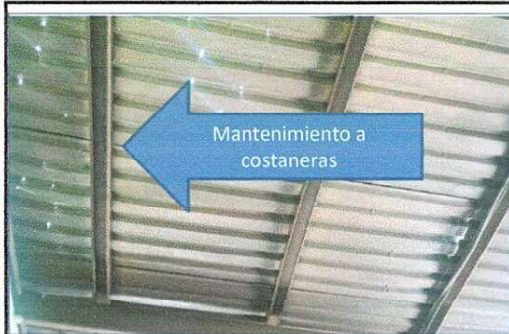
Foto 7: 1.3.1 y 1.4.1 Sustitución de lámina por lámina troquelada aluzinc calibre 26 y Mantenimiento a estructura de soporte de metal (costaneras)
