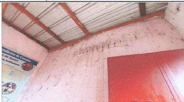
FOTO 2: SELLADO DE JUNTA ENTRE LA CUBIERTA DE LAMINA Y MURO CON ESPUMA EXPANDIDA DE POLIURETANO MAS CHAFLAN DE CONCRETO
