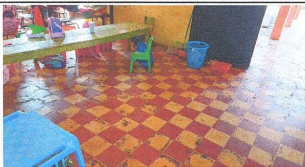
FOTO 1: SUSTITUCION DE PISO POR PISO CERAMICO MAS NIVELACION DE BAS DE CONCRETO
