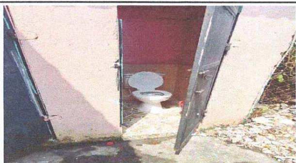
FOTO 3: SUSTITUCION ACCESORIOS EN INODOROS
