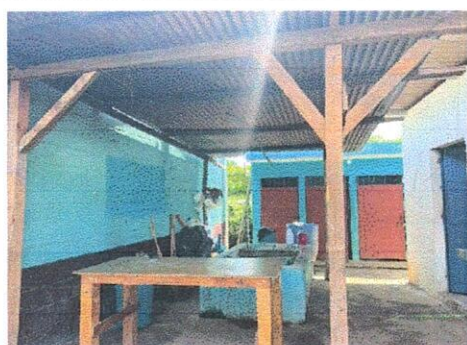
FOTO 3: Suministro de estructura portante de metal + lámina troquelada aluzinc calibre 26
