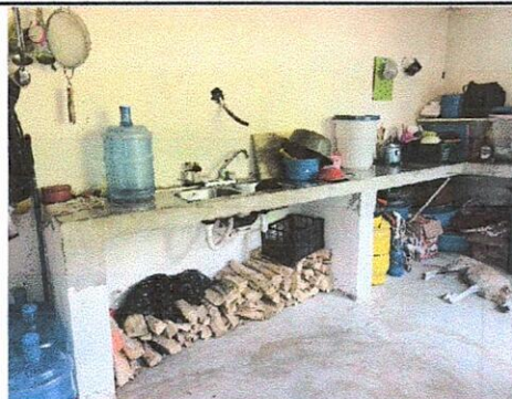
FOTO 2: Suministro de gabinetes de concreto de 0.60 x 2.00 (revestido de azulejo)
