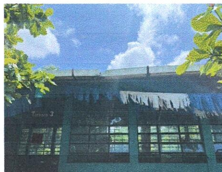
FOTO 4: Sustitución de canales de metal + bajadas de agua pluvial de 3"
