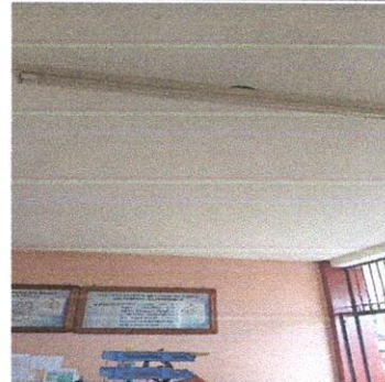
FOTO 4: Reparación de sistema eléctrico de iluminación (34 luminarias led + plafoneras)
