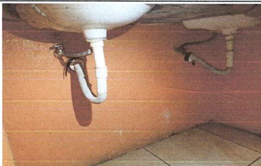
FOTO 5: Suministro de lavamanos (incluye accesorios)
