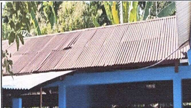
Foto 2: Sustitución de lamina por lamina troquelada en modulo 1
