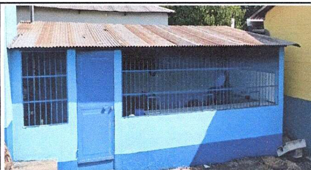
Foto 3: levantado de block par elevar el nivel de techo en cocina
