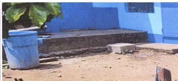
Foto 2: Reparación de loza de patio y grada.
