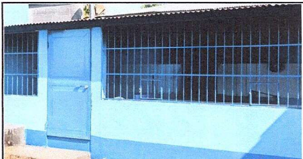
Foto 4: Levantado de muro para elevar el nivel del techo en cocina
