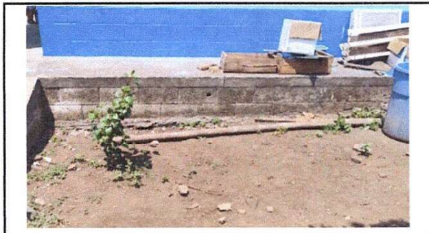
Foto 6: Reparación de la losa más grada de concreto
