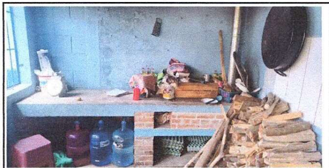
Foto 3: Revestimiento de mesa de concreto con azulejo
