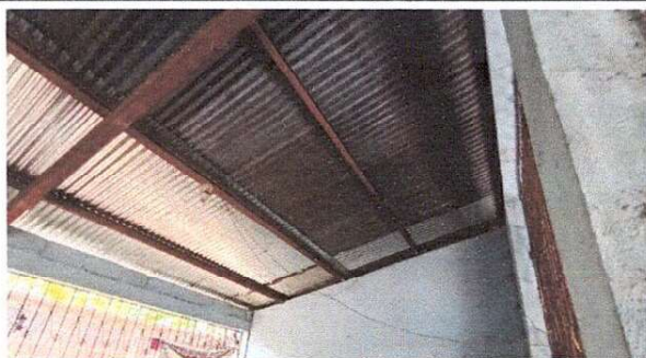
Foto 1: Mantenimiento de estructura de soporte del modulo 1
