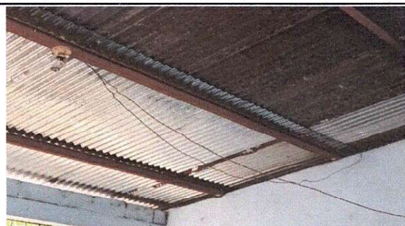
Foto 4: Reparacion de sistema electrico en mdulo 1 y 2
