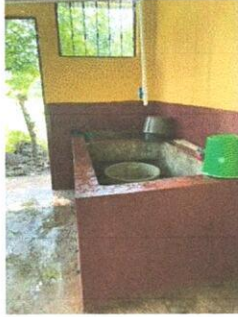
FOTO 1 :REVESTIMIENTO DE PILETA CON AZULEJO + CAMBIO DE VALVULA + DRENAJE DE 1.50 X 0.90
