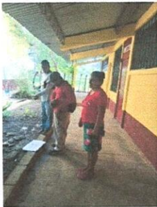
FOTO 5: SUMINISTRO DE LOSA DE CONCRETO
