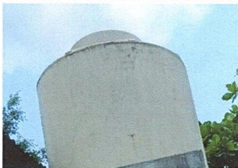
FOTO 3: Sustitución de deposito de agua 2,500 lt. Incluye accesorios
