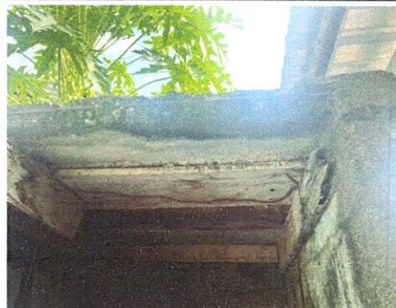
FOTO 4: Reparación de muros divisorios de servicios sanitarios + base de concreto para tanque elevado (losa)
