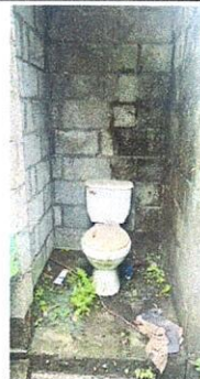
FOTO 2: Reparación de muros divisorios de servicios sanitarios
