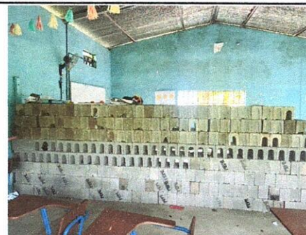
FOTO 6: Cerramiento de muro divisorio para módulo de aulas
