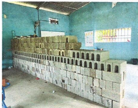
FOTO 1: Cerramiento de muro divisorio para módulo de aulas
