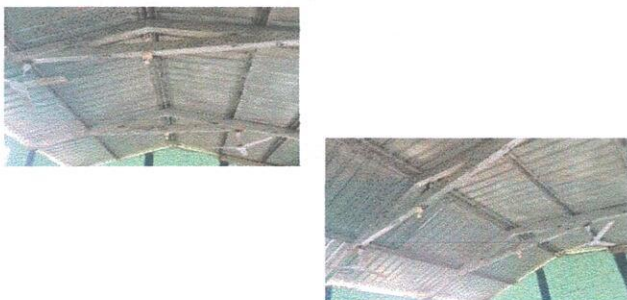
FOTO 5: Aplicación de pintura en estructura metalica
