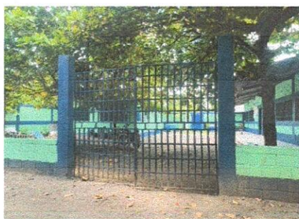
FOTO 3: Sustitución de portón 3.8 m x 2.40 m
