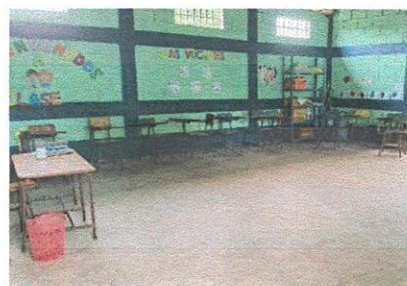
FOTO 6: S Aplicación de piso ceramico en aulas
