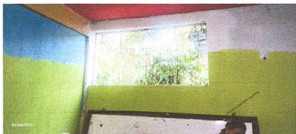
SUMINISTRO DE VENTANA DE PVC
