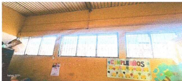
SUMINISTRO DE VENTANA DE PVC
