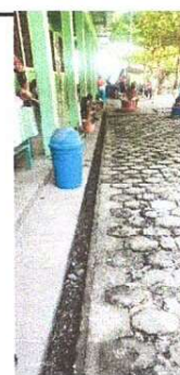
SUMNIISTRO DE CUNETETA DE CONCRETO MAS REJILLA DE METAL
