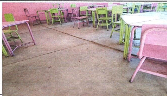
FOTO 1: SUSTITUCIÓN DE PISO DE CONCRETO POR PISO CERÁMICO EN AULA DE PARVULO.
