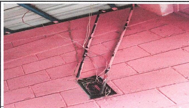
FOTO 2: SUSTITUCIÓN DE SISTEMA ELÉCTRICO EN EL CENTRO EDUCATIVO
