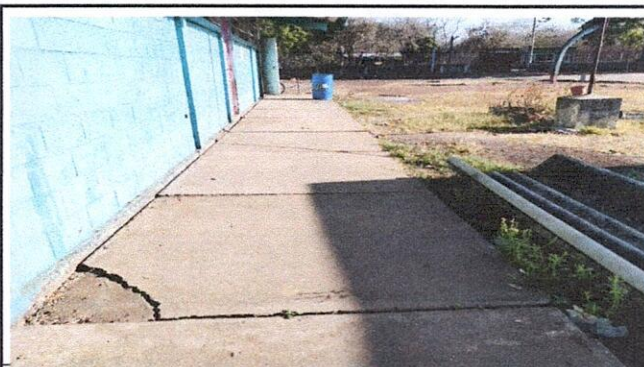
FOTO 4: SUSTITUCIÓN DE BANQUETA DE CONCRETO POR CONCRETO
