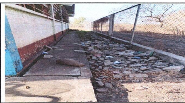
FOTO 6: SUSTITUCIÓN DE BANQUETE DE CONCRETO, POR CONCRETO.
