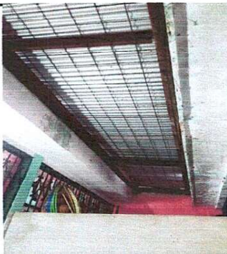
Foto 3: Sustitución de lámina, por lámina troquelada y acanalada aluzinc calibre 26 de cocina, Sustitución de estructura de metal tipo rejilla (seguridad del techo de lámina).
