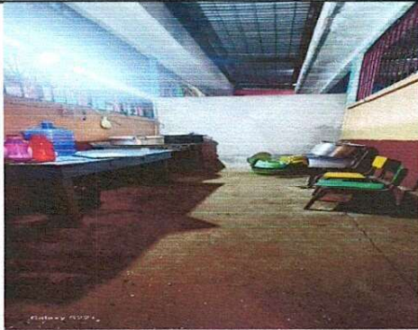
Foto1: , sustitución de piso cerámico, pintura en muros interiores y exteriores de cocina, suministro de pila de dos lavaderos (fundida en el lugar)
