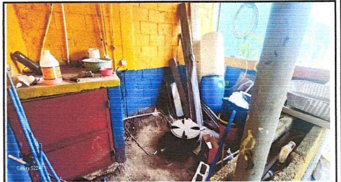
Foto 4: Sustitución de bomba de agua 1HP, Suministro de tubería PVC de agua potable para distribución de agua potable + accesorios (incluye: excavación, colocación de tubería, relleno de zanja), Suministro de flipón. Suministro de cable Suministro de tomacorriente en interperperiado + entubado para alimentación de bomba.
