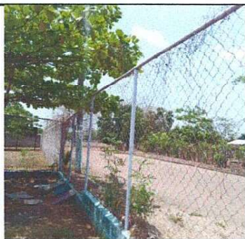
FOTO: SUSTITUCION DE MUROS PERIMETRAL CON BLOCK + MALLA + COLUMNAS DE CONCRETO ARMADO
