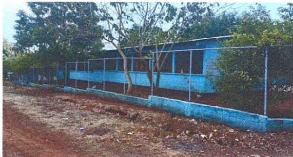
FOTO: SUSTITUCION DE MUROS PERIMETRAL CON BLOCK + MALLA + COLUMNAS DE CONCRETO ARMADO
