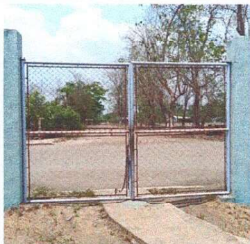
FOTO 3: SUSTITUCION DE PORTON DE 3 X 2.0 MTS MAS TECHO TIPO CAPOTE DE METAL
