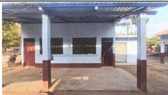
FOTO 1: SUSTITUCION DE PISO DE CONCRETO POR PISO CERAMICO AULA DE PRVULOS Y CORREDOR
