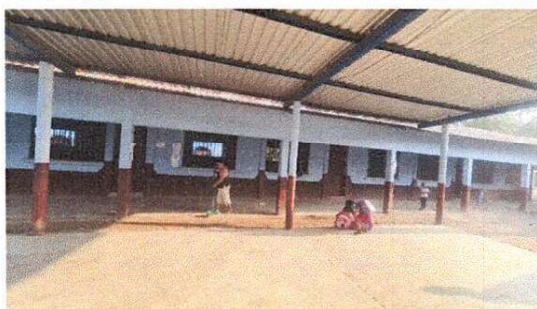
FOTO 3: PINTURA EN MUROS INTERIORES Y EXTERIORES
