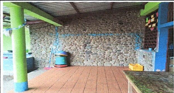
FOTO 1: SUMINISTRO DE MUEBLE DE COCINA DE CONCRETO EN 4.50 * 0.60*0.90 MTS REVESTIDO DE AZULEJO + PUERTA DE REJILLA DE 09. * 0.9 MTS
