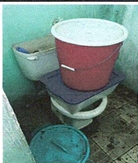
FOTO 3: SUSTITUCION DE SANITARIOS + ACCESORIOS
