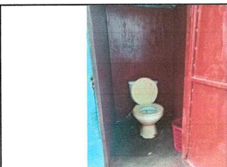
FOTO 3: Sustitución de inodoro
