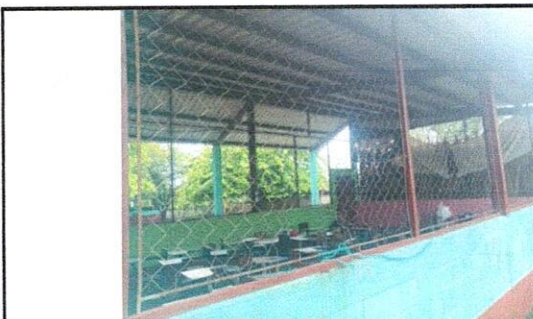
FOTO 5: Cerramiento de muro de malla, por block
