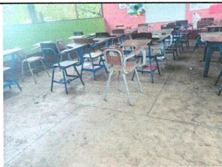
FOTO 4: Sustitución de piso de granito, por piso cerámico, en módulo de aulas y área de corredor frente a aulas
