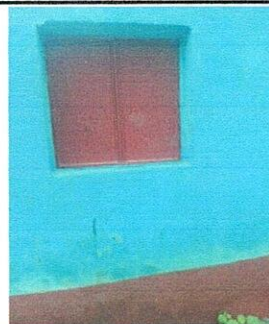
FOTO 2: Apertura de vano de puerta + suministro de puerta de metal de 0.70 x 1.30
