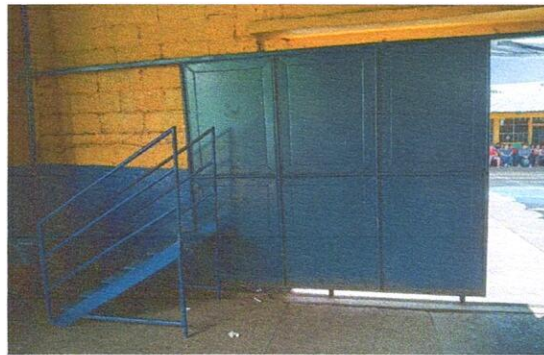
FOTO 2: MANTENIMIENTO DE PORTON Y CAMBIO DE RODOS
