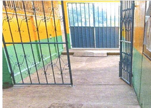
FOTO 6: SUSTITUCION DE DE TORTA DE CONCRETO POR PISO CERAMICO ANTIDESLIZANTE PARA PATIO + SUSTITUCION DE PORTON DE METAL POR PORTON DE METAL
