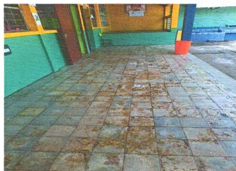
FOTO 4: SUSTITUCION DE PISO POR PISO CERAMICO
