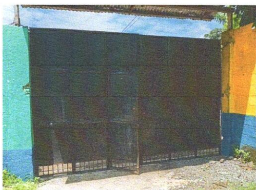
FOTO 3: MANTENIMIENTO DE PORTON DE METAL
