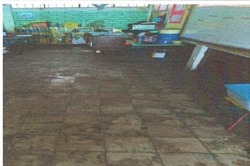
FOTO 5: SUSTITUCION DE PISO POR PISO CERAMICO
