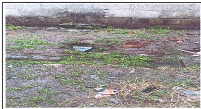
FOTO 4: Sustrucción de tubería de drenaje en fosa septica.
