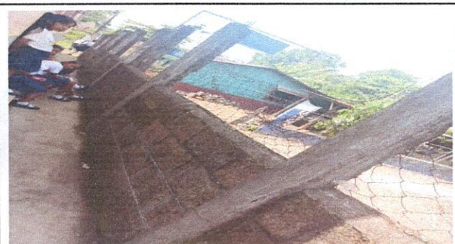
FOTO 5: Sustrucción de malla galvanizada por marcos de malla galvanizada con tubo galvanizado
