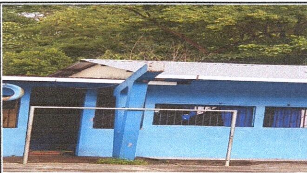
FOTO 4: sustrucción de estructura de soporte incluye levantado de block para mejorar altura en aula, aplicación de pintura en muros
