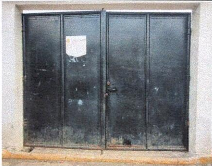
FOTO 1: Mantenimiento de portón de metal de ingreso principal de 2.00 x 2.50
