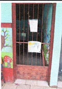
FOTO 5: Sustitución de puerta, por puerta de metal de 1.00 x 2.00
