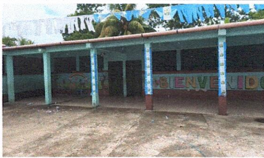
FOTO 3: Sustitución de lámina, por lámina troquelada aluzinc calibre 26, Sustitución de malla por balcones de metal 1.50 x 2.50
