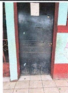
FOTO 6: Mantenimiento de puerta de metal de 1.00 x 2.00 (cepillado, lijado y aplicación de pintura anticorrosiva)
