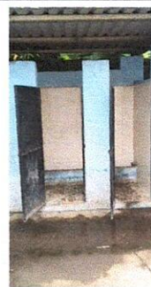
FOTO 4: Suministro de inodoros, Mantenimiento de puerta de metal de 1.00 x 2.00 (cepillado, lijado y aplicación de pintura anticorrosiva)
