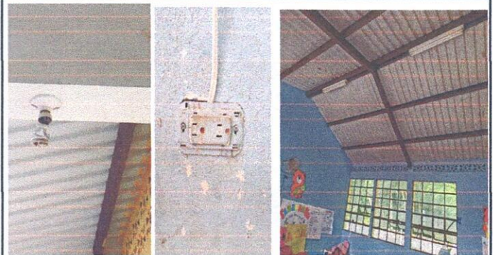
FOTO 4: sustitución de cableado en 3 aulas para alumbrado, cable No 12, instalación de tubería y accesorios para introducir cableado hacia plafoneras, Cambio de lámparas por focos con plafoneras y tomacorrientes
