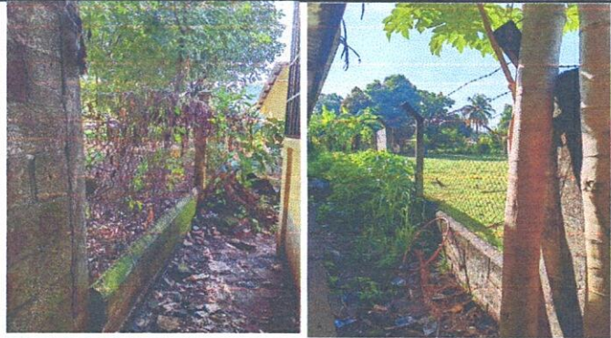
FOTO 1: Suministro de block para circulación de muro perimetral
