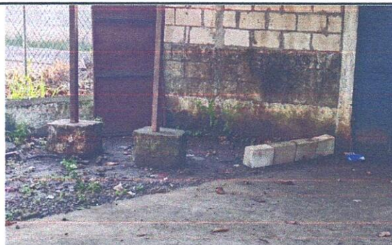
FOTO 8: Sustitución de borde para evitar lodo en paso peatonal alumnado fluidez de agua pluvial
