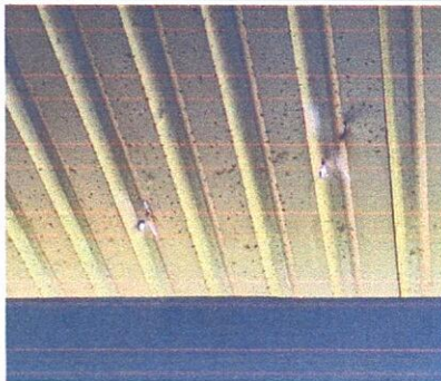
FOTO 5: Sustitución de lámina, por lámina troquelada aluzinc calibre 26 c/elementos fijacion en aula
