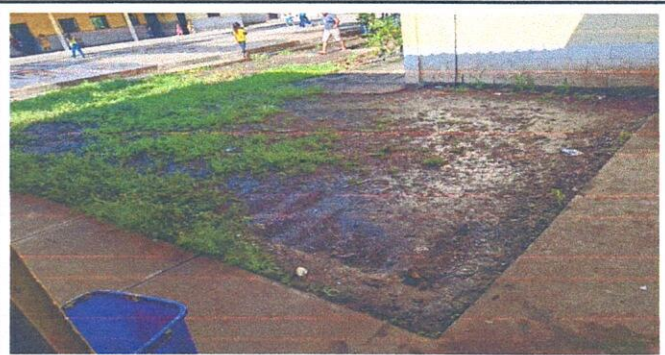
FOTO 2: sustitución de piso de tierra a piso de torta de cemento
