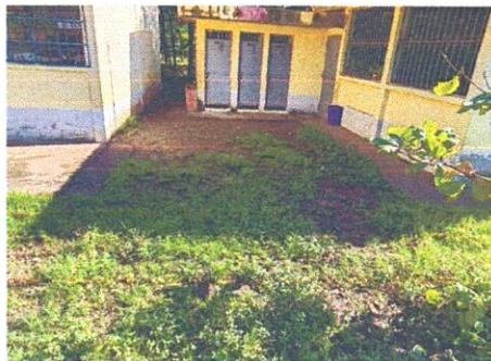
FOTO 3: continuación de sustitución de piso de tierra a piso de torta de cemento
