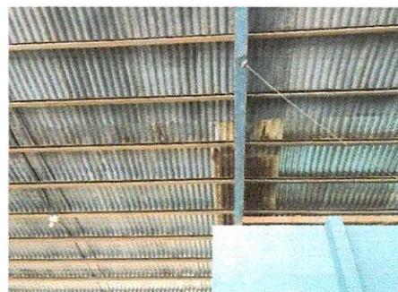
FOTO 4: Sustrucción de lámina, por lámina troquelada aluzinc calibre 26,
