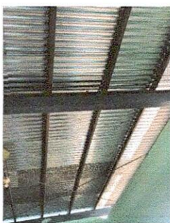
FOTO 3: Sustrucción de lámina, por lámina troquelada aluzinc calibre 26
