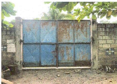
FOTO 1: Sustrucción de portón
