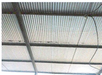
FOTO 5: Sustrucción de lámina troquelada aluzinc calibre 26
