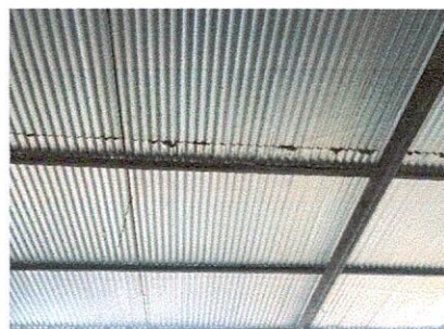
FOTO 6: Sustrucción de lámina, por lámina troquelada aluzinc calibre 26
