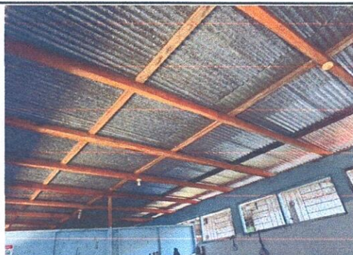
Foto 3: Sustitucion de lamina, por lamina troquelada o acanalada aluzinc calibre 26, Sustitucion de estructura de soporte de madera por metal, Reparacion de cableado electrico de aulas, Sustitucion de flaponeras, Sustitucion de focos ahorradores, Sustitucion de interruptores Sustitucion de tomacorrientes Suministro de ventiladores en aulas
