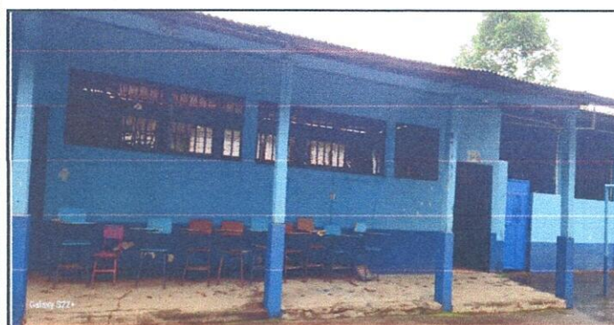
Foto 5: Sustitucion de piso de torta de concreto por piso ceramico antideslizante de corredor de aulas, Suministro de fundicion de columnas de concreto armado de corredor.
