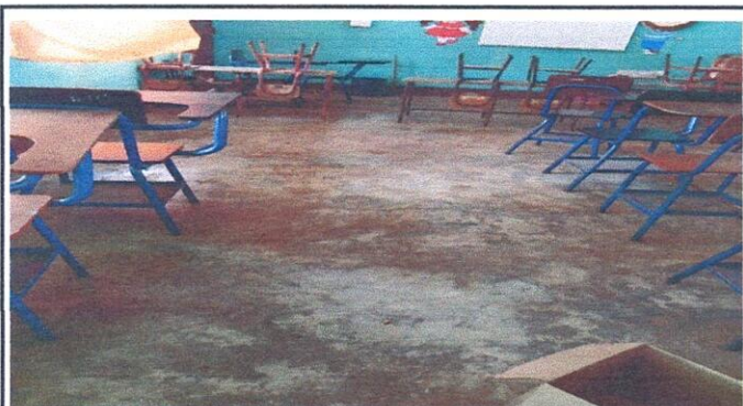
FOTO 3: Sustrucción de torta de cemento, por piso cerámico en aula 2
