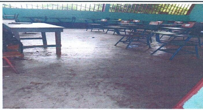
Foto 2: Sustrucción de torta de cemento, por piso cerámico en aula 1
