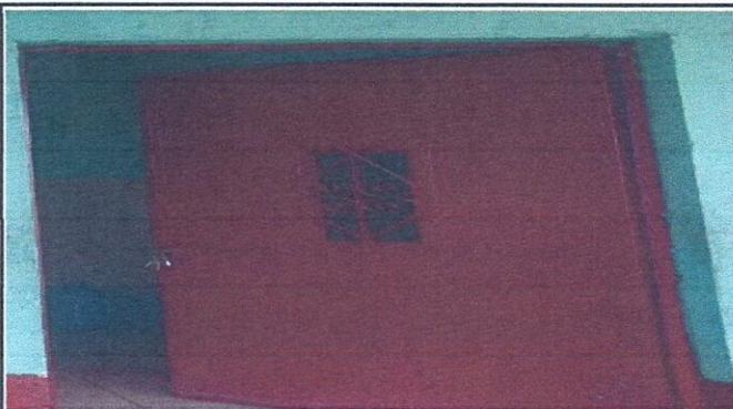
FOTO 1: Sustrucción de puerta de metal. Por puerta de metal.
