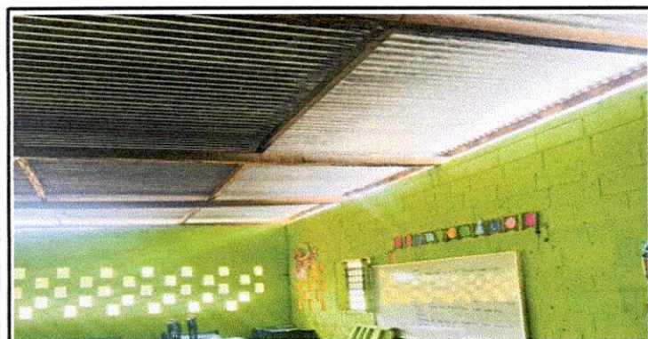
Sustitución de cubierta de lámina y sustitución de soporte de madera por metal.
