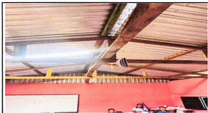
Sustitución de soporte de madera por metal.
