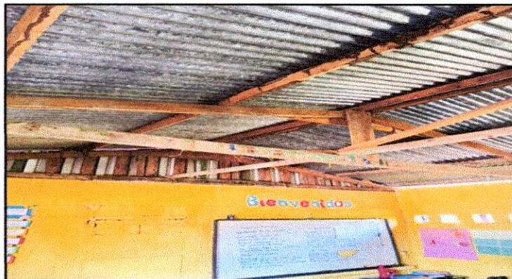
Sustitución de cubierta de lámina y sustitución de soporte de madera por metal.
