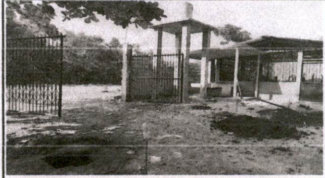
Foto 2: Suministro de losa de patio de concreto de 0.1 de grosor.
