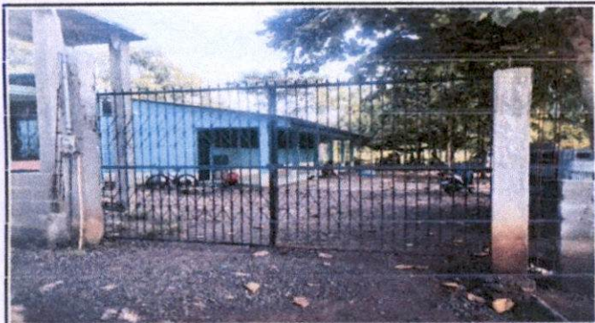
suministro de estructura de metal en el ingreso principal,
