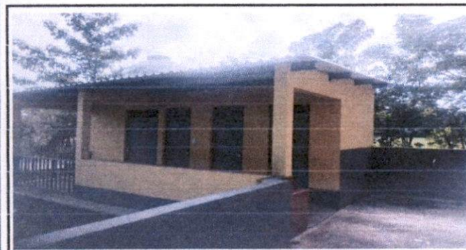
levantado de block de 5 hiladas, suministro de balcón de metal.
