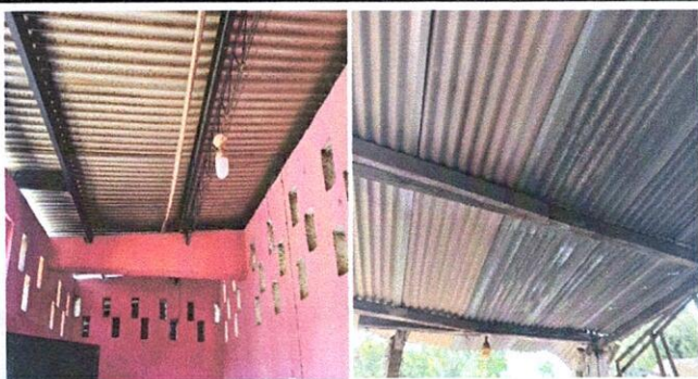
Foto 3: Demolición y cambio de techo completo.
