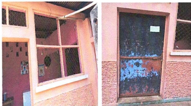
Foto 1: Fabricación e instalación de balcón y puerta.
