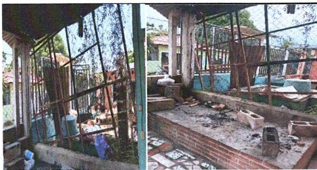
Foto 6: Sustitución de malla galvanizada por pared de block.
