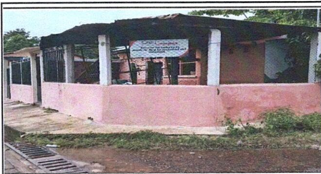
Foto 5: Demolición y sustitución de muro perimetral de concreto.
