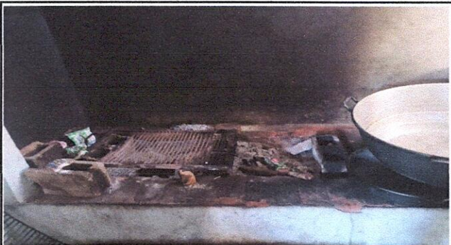
Foto 2: Mantenimiento a polleton (aplicación de repello, suministro de parrilla con varilla Ø 3/8")
