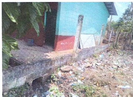
SUSTITUCION DE MURO PERIMETRAL POR TUBO GALVANIZADO + MALLA GALVANIZADA + BASE CONCRETO + PLANA DE METAL
