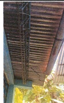
FOTO 4: Sustitución de lámina, por lámina troquelada aluzinc calibre 26,
