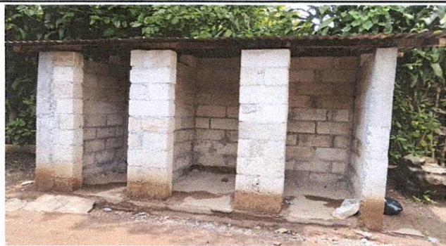
FOTO 1: Suministro de puerta de metal de 1.00 x 2.00, Sustitución de inodoro (incluye accesorios)
