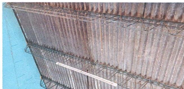
FOTO 6: Sustitución de lámina, por lámina troquelada aluzinc calibre 26
