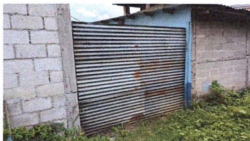
FOTO 2: SUSTITUCION DE PORTON DE MADERA + LAMINA POR PORTON DE METAL DE 3 X 2.10
