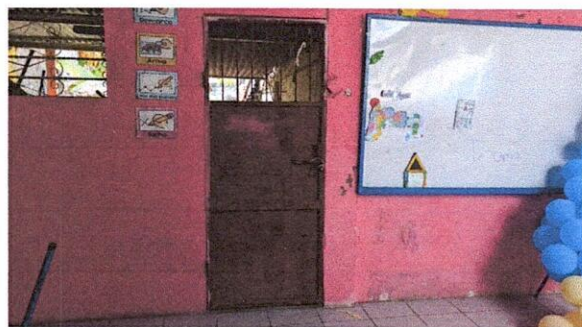
FOTO 4: MANTENIMIENTO DE PUERTA DE METAL
