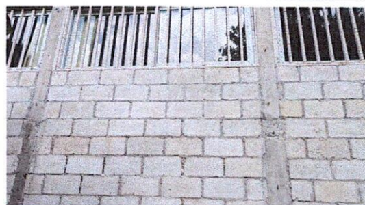
FOTO 6: SUMINISTRO DE REPELLO
