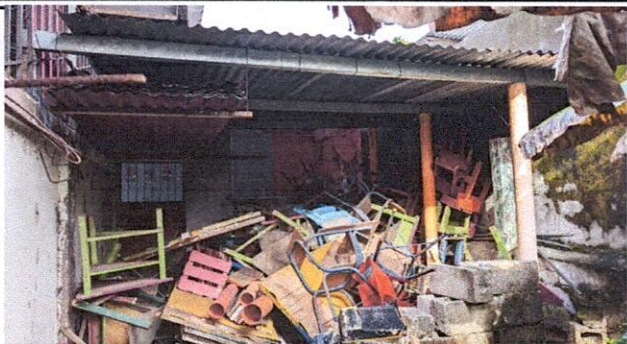
FOTO 1: AMPLLIACION DE CUBIERTA DE LAMINA TROQUELADA CALIBRE 26 + ESTRUCTURA DE SOPORTE
