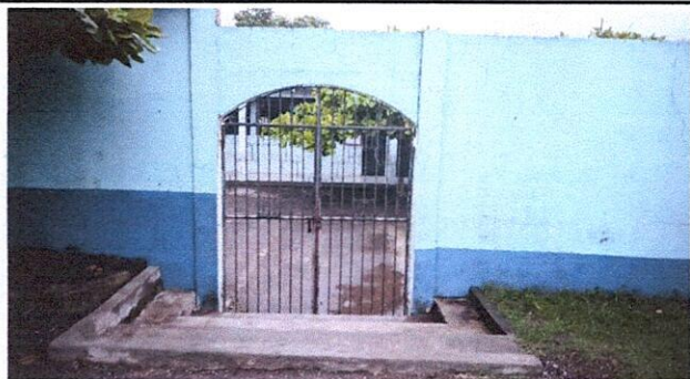
FOTO 3: VICERA DE METAL EN PORTON INCLUYE COSTANERA Y LAMINA TROQUELA 3 X 1.80 MTS
