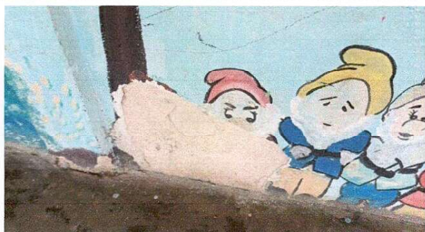
REPELLO EN MUROS DE AULAS
