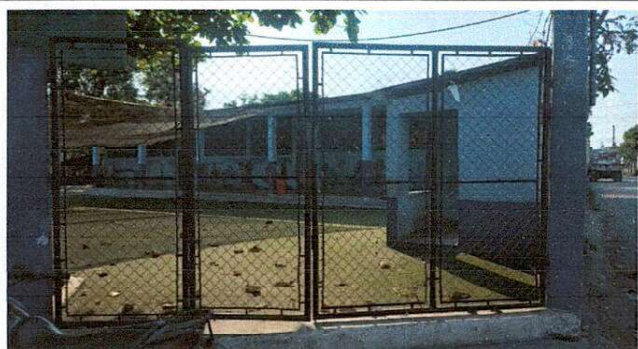
SUSTITUCION DE PORTON DE MALLA POR PORTON DE METAL DE 4.00 X 3.50 MTS
