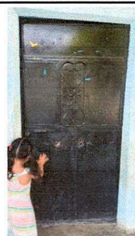
SUSTITUCION DE PUERTA DE METAL
