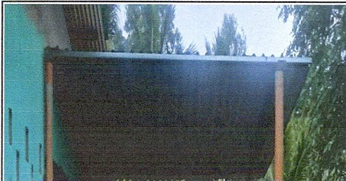
FOTO 1: Sustrucción de techo lamina.
