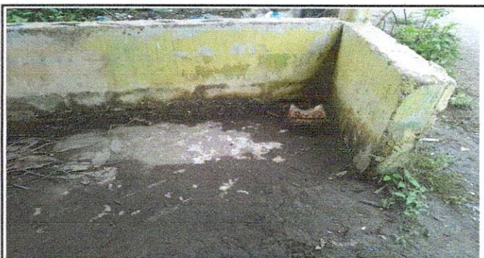
FOTO 3: Sustrucción pared en cocina.
