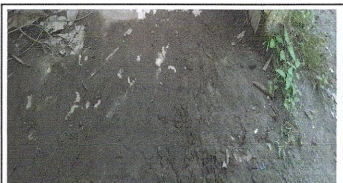
FOTO 4: Sustrucción de te torta de concreto.
