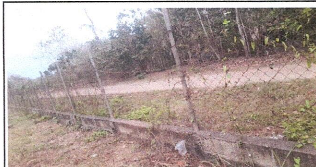
Foto 6: Sustrucción de malla galvanizada por block incluye elementos de refuerzo
