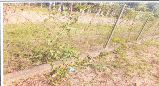
Foto 3: Sustrucción de malla galvanizada por block incluye elementos de refuerzo
