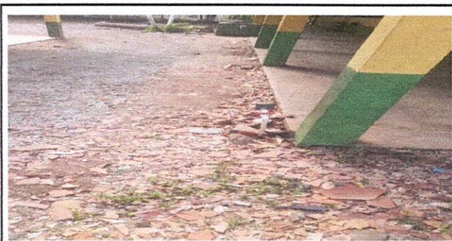
Foto 4: Sustitución de red de abastecimiento de agua para cocina
