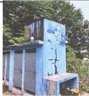
REPARACION DE MURO Y CISTERNA DE CONCRETO
