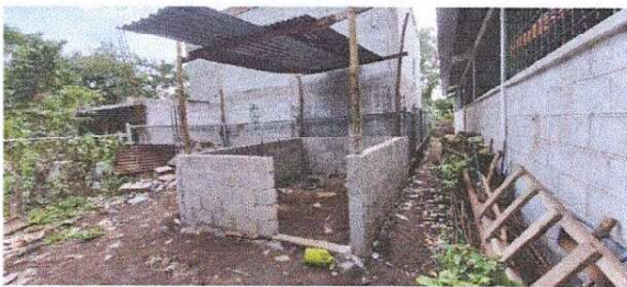
SUMINISTRO DE CUBIERTA DE LAMINA
