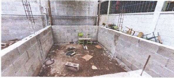
SUMINISTRO DE PISO CERAMICO MAS BASE DE CONCRETO
