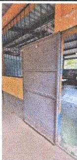
SUSTITUCION DE PUERTAS EN AULAS
