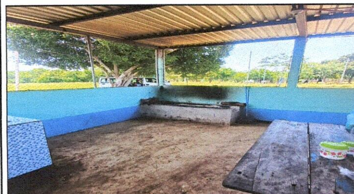
Sustitución de piso de granito, por piso cerámico en cocina.
